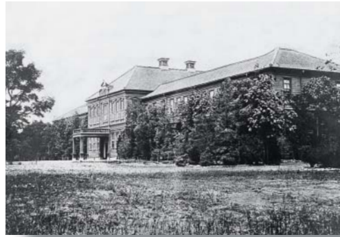
明治23年5月に新築された当時の校舎。奏楽堂は建物の2階中央部分に位置し、その両側に校長室、女教員室、教室、練習室などがあつた。1階は事務室、男教員室、教室、練習室、食堂、小使室など。生徒が校舎に出入りする際は、正門から玄関に向かって建物の左端に「男生徒昇降口」、右端に「女生徒昇降口」が別々にあつた。
